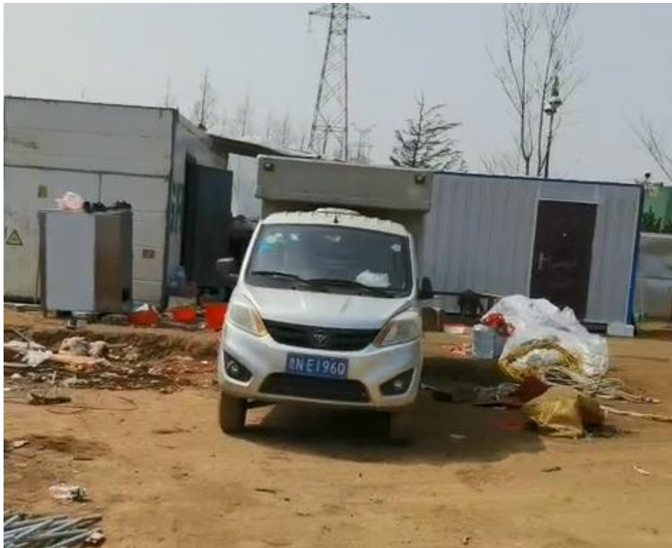
施工临建区板房
