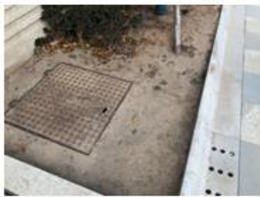
雨水检查井及雨篦子
